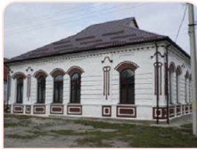
בית מדרשו של הרה"ק מאפטא ז"ע במזיבו' שבאוקראינה אחרי שיפונו עיי אנדו' אהלי צדיקים
